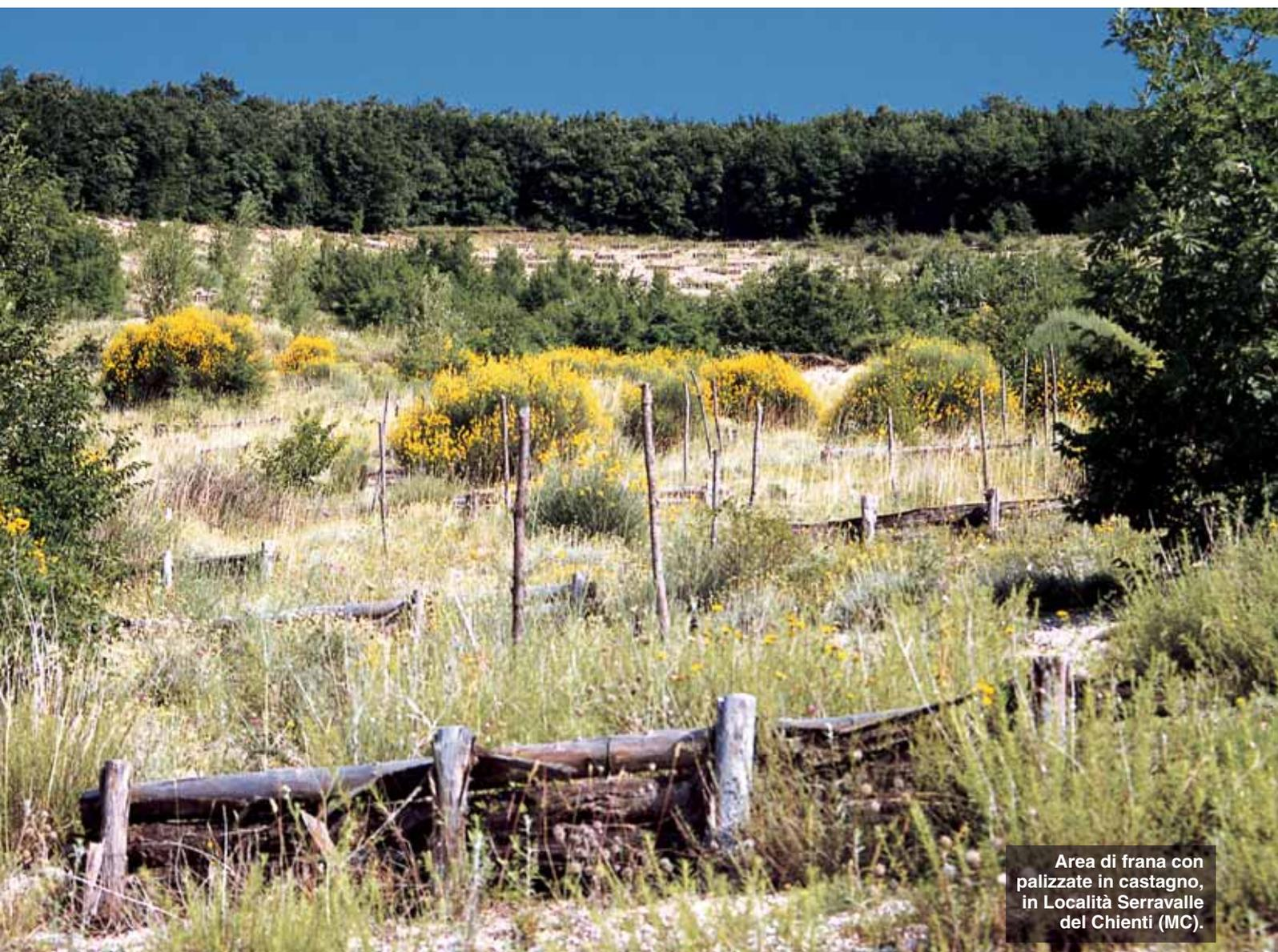
Area di frana con palizzate in castagno, in Località Serravalle del Chienti (MC).
